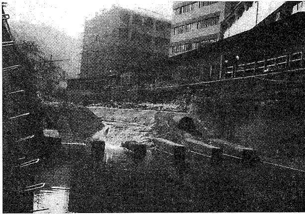
中華工專河段河道皆為混泥土所覆蓋，本段為淨水池之水工設施，河岸景觀單調，毫無綠意可言。
