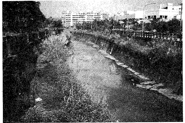
中華工專下游及迴水河段，河道兩岸雖有植栽，然樹種單一，堤岸上雜草叢生，景觀無法與上游環境之美相比。
